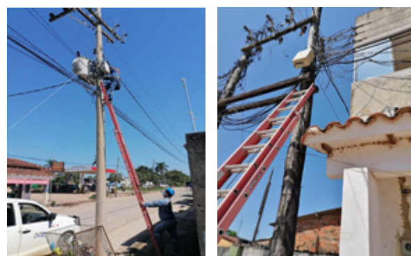
AETN fiscaliza la instalación de Registradores de Tensión, Trinidad - Beni
